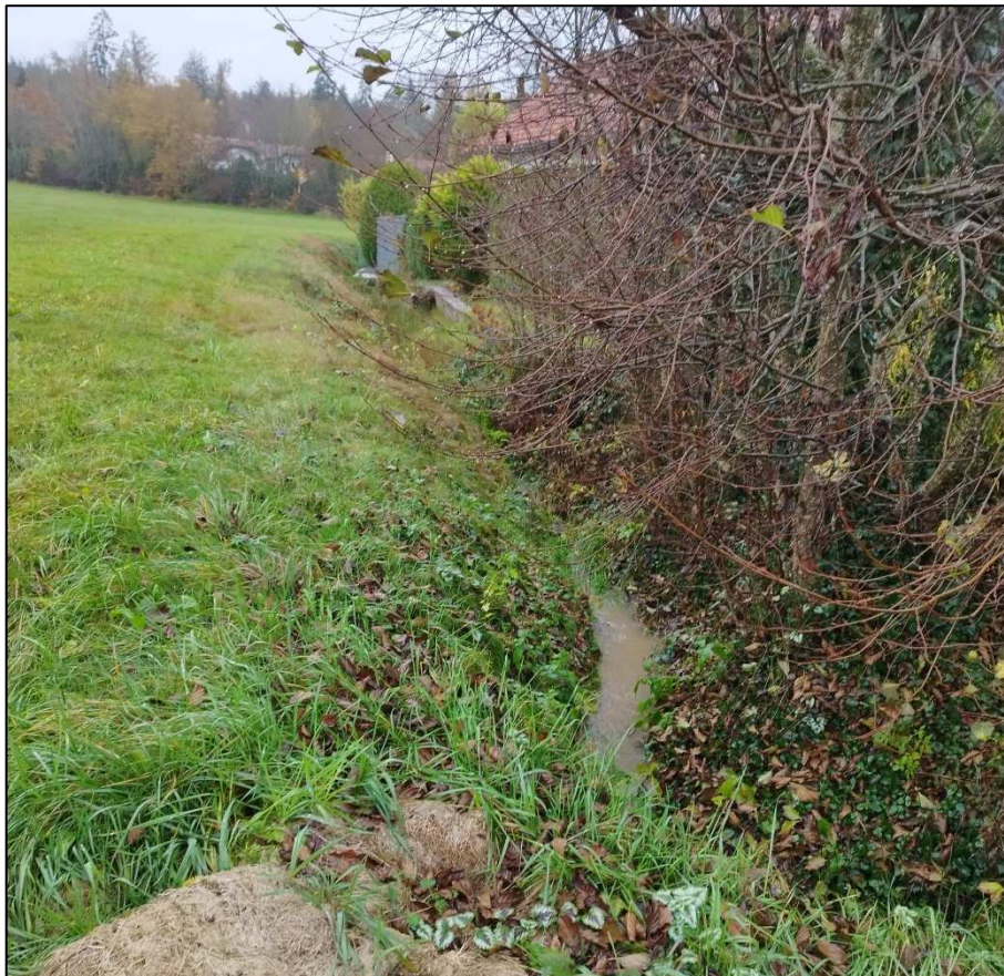
Graben an der Nordseite Bebauung Hundshauser Straße
