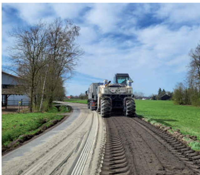
Vorbereitung der tragbaren Fahrbahnfläche durch PANMAX Spezialverfahren
