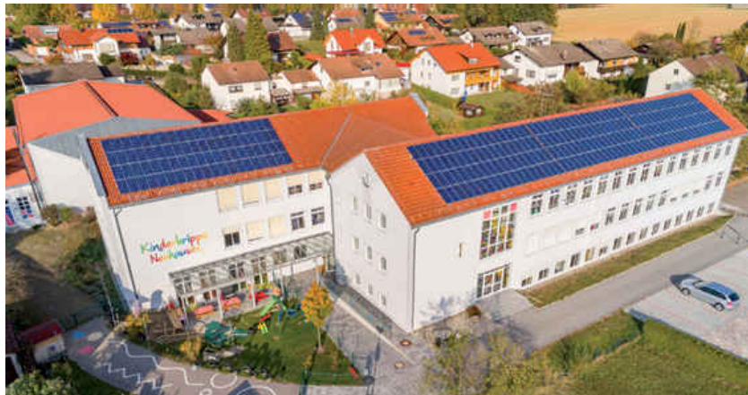
Grundschule und Kinderkrippe
