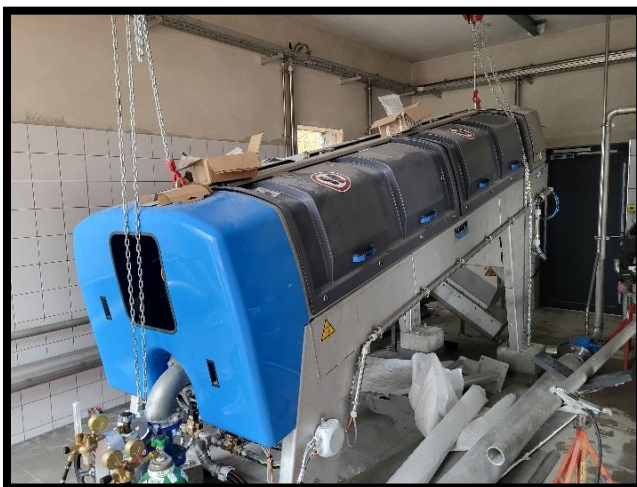
Schlammwässerungsanlage
