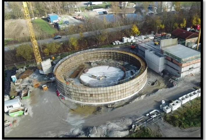
Parallel zu den Baumeisterarbeiten wird der Einbau der technischen Ausrüstung wie Sandfanganlage, Belüftungsanlage und Elektroinstallation durch die Fa. Scharrtec aus Hunderdorf vollzogen.
