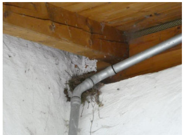
Abbildung 5: Nest eines Gebäudebrüters
