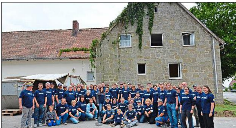
Das Alte Schulhaus soll zu einem Dorfkulturhaus werden. Dazu haben die Aschenauer nun selbst einiges beigetragen.
